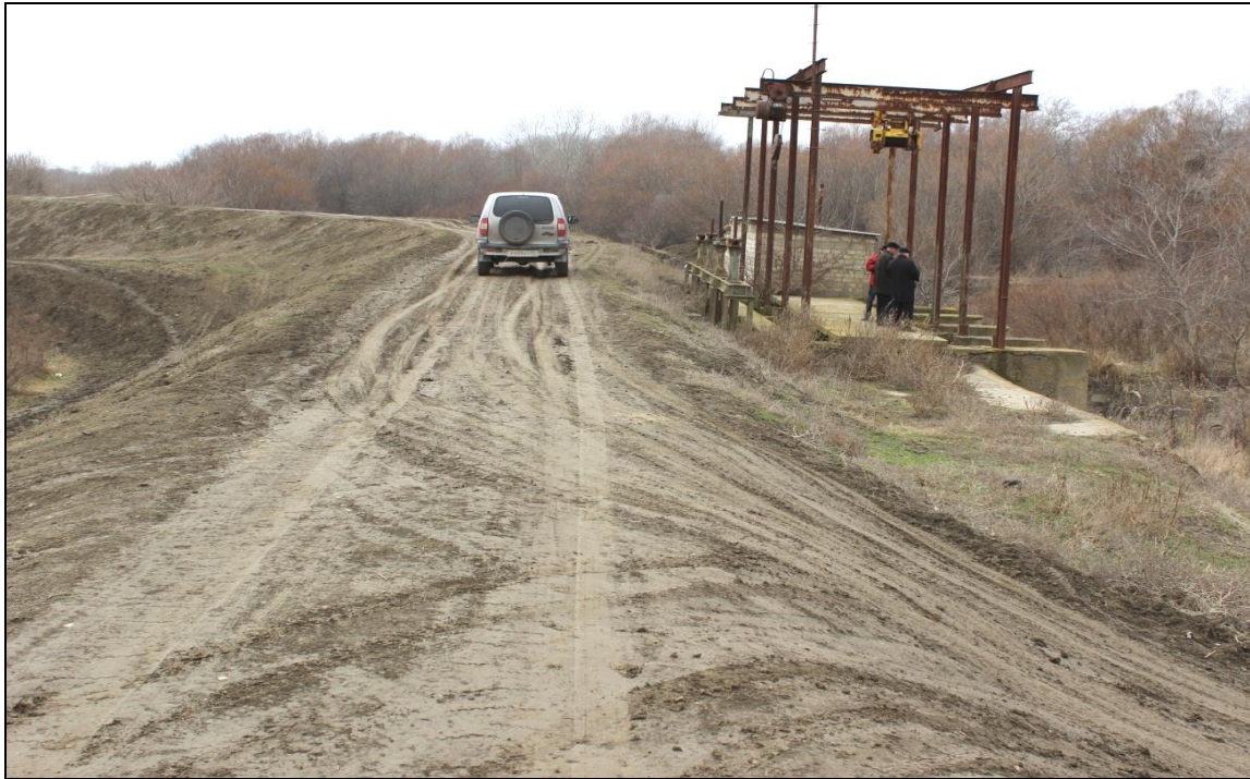
Рисунок 2.12. Водозаборное сооружение на правом берегу р. Терек в районе ПК-775 (на рис. 2.8 этот пикет обозначен кружком К-4)
