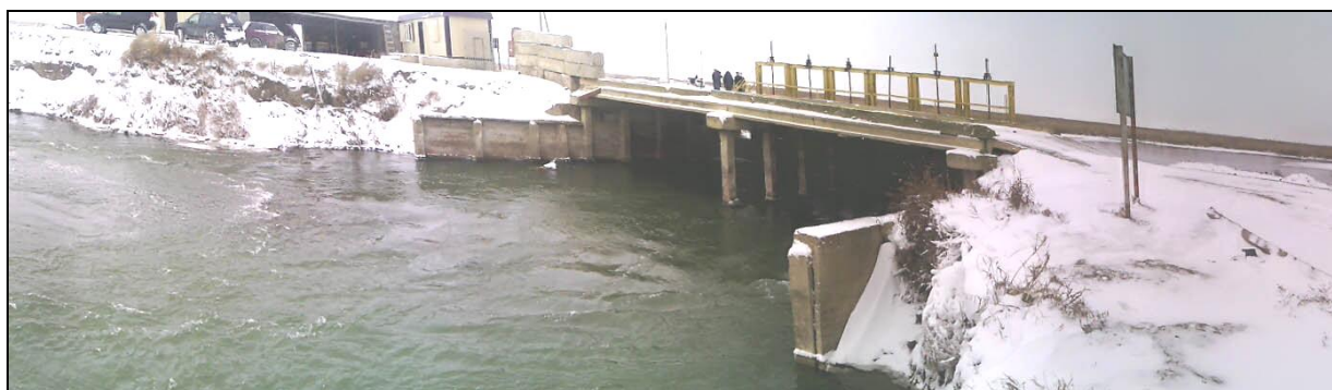
Рисунок 1.19. Нижний бьеф Гаруновского водоотводного сооружения, декабрь 2012 г.
