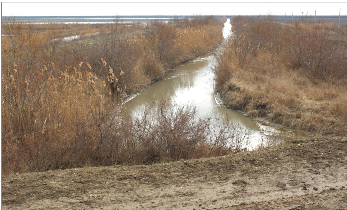
Рисунок 2.13. Отводящий канал от водозаборного сооружения на участке р. Новый Терек в районе ПК-775
